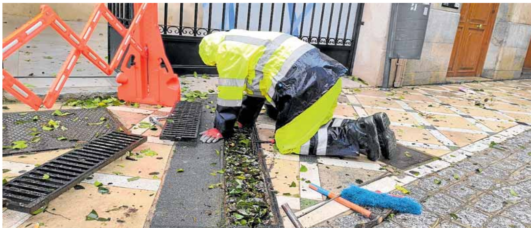
Limpieza de imbornales para evitar que se acumule el agua. J. JIMÉNEZ
